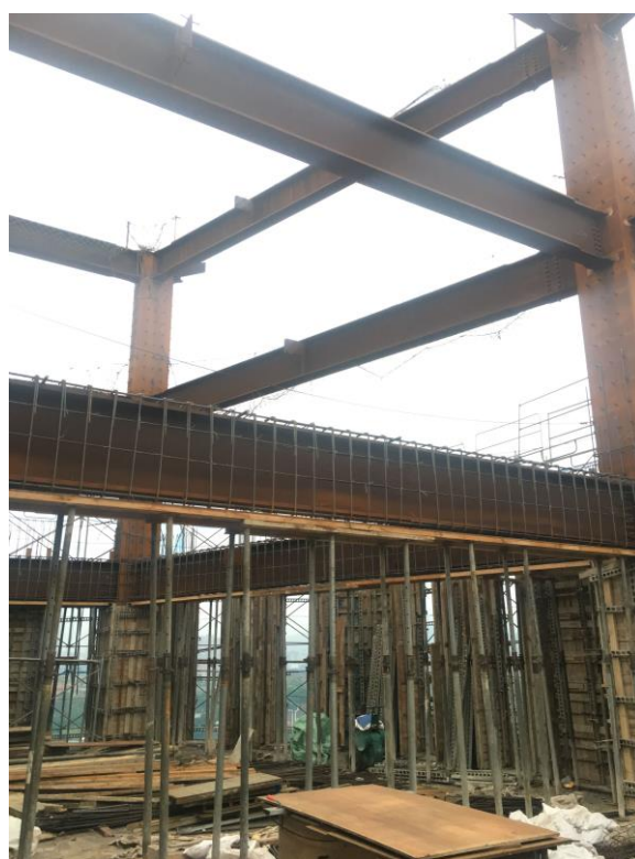
2019/4/11 十樓工地現況
