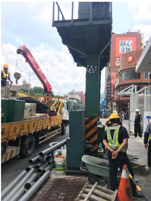
8/21 台電高架變壓器遷移工程
